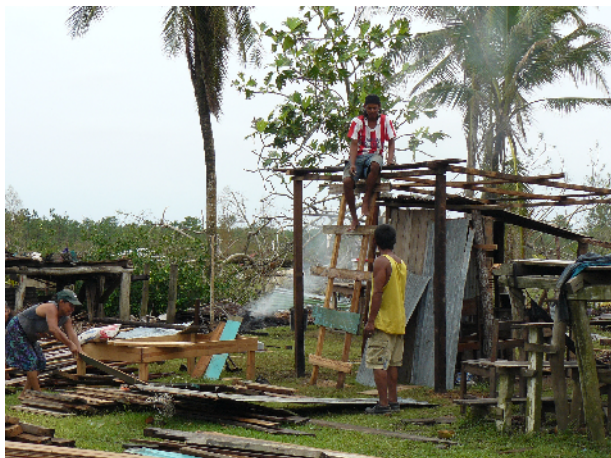
Aufräumarbeiten nach dem Hurrikan Mitch
